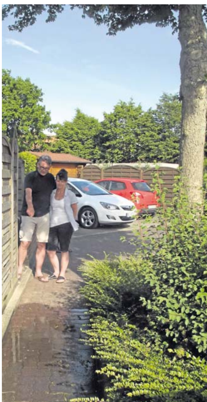
Michael und Andrea Paul wohnen am Leharweg 30 und ärgern sich über den Baum vor ihrem Garten, der mit seinem Wurzelwerk Schäden am Bürgersteig, an der Grundstücksabgrenzung und auf ihrem Grundstück selbst verursacht hat. RN-FOTO ENGEL
