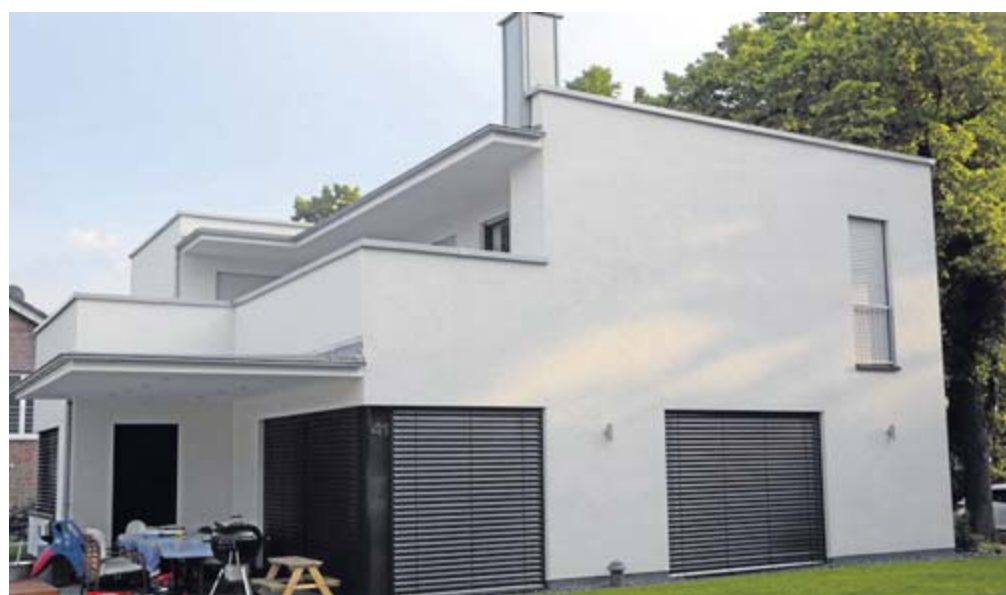
Dieses Haus ist für den Tag der Architektur NRW ausgewählt. FOTO KRAFFT
