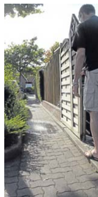
Michael Paul setzt den Bordstein unter Wasser, um zu zeigen, wie das Wasser in der Mulde stehen bleibt. Im Winter herrscht hier akute Rutschgefahr. RN-FOTO ENGEL
